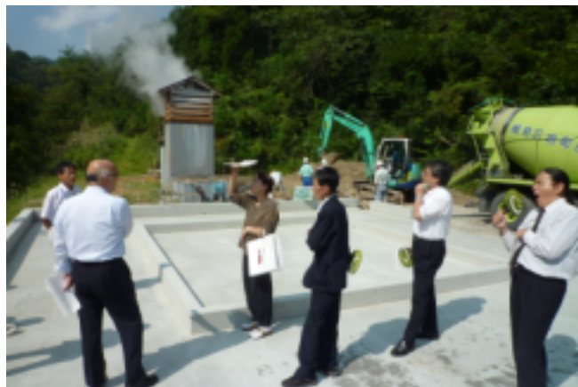
白い湯気をあげる源泉鷹の湯3号。バイナリー発電の機械等の建屋を建設中で、敷地造成を行っていた(9/15)。
